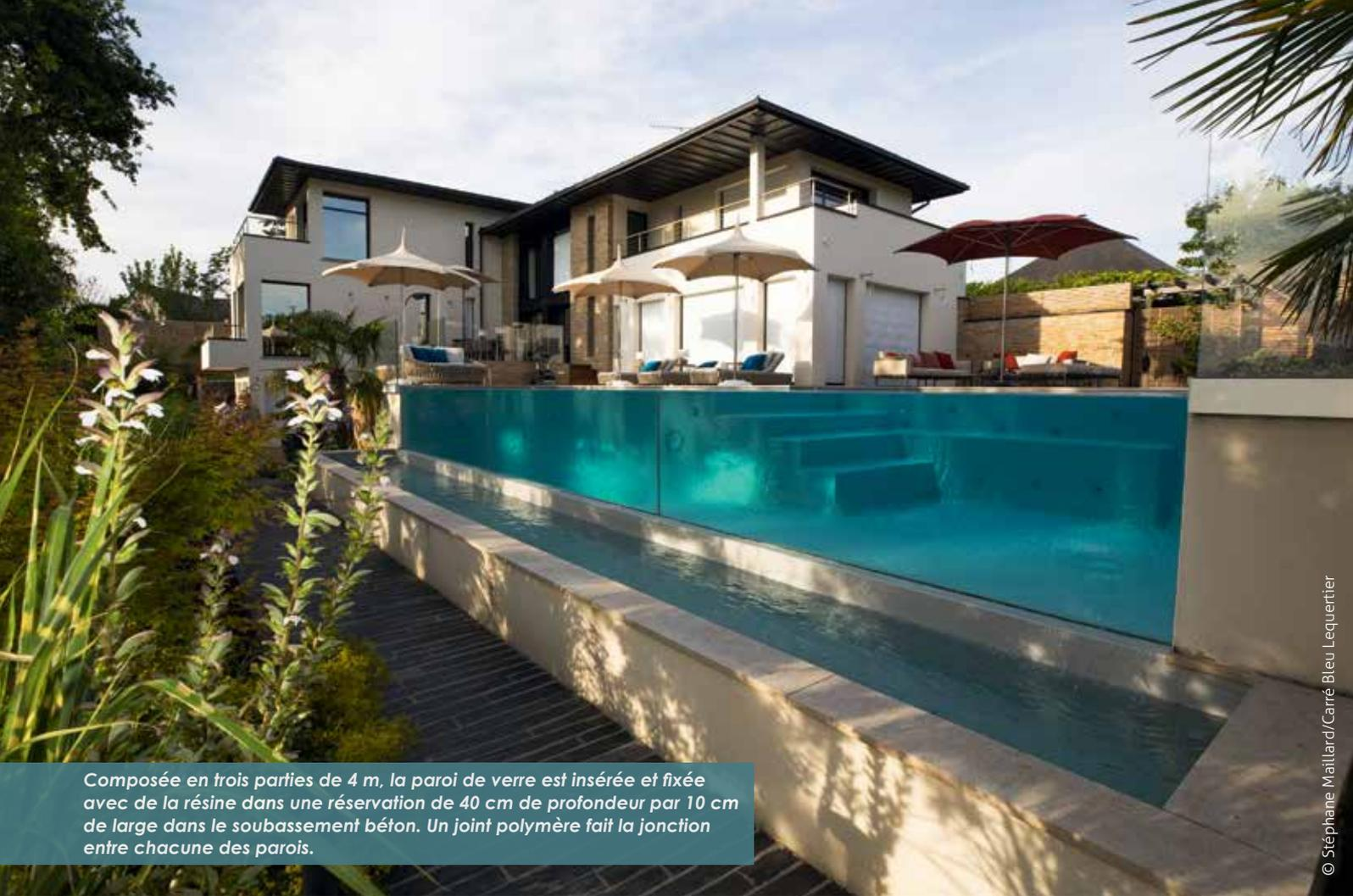
Composée en trois parties de 4 m, la paroi de verre est insérée et fixée avec de la résine dans une réservation de 40 cm de profondeur par 10 cm de large dans le soubassement béton. Un joint polymère fait la jonction entre chacune des parois.
